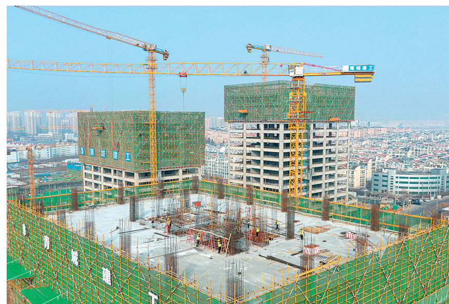
■2023年2月8日,李沧区中化·云谷项目施工现场,工人正在实施混凝土浇筑作业。张鹰摄
