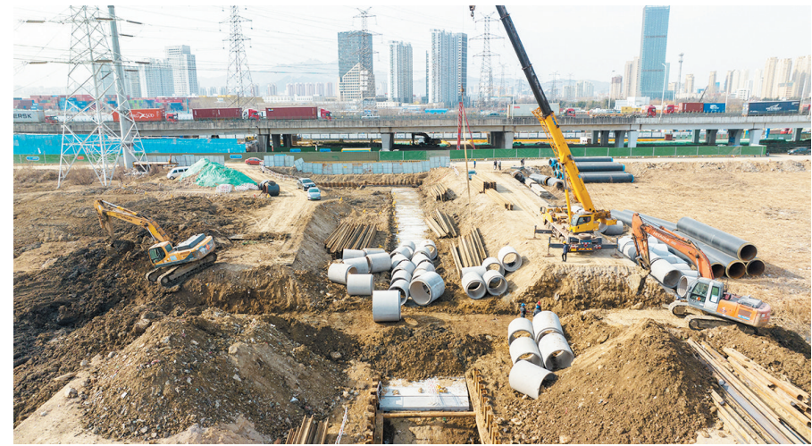
■大唐热力出线项目施工现场。
