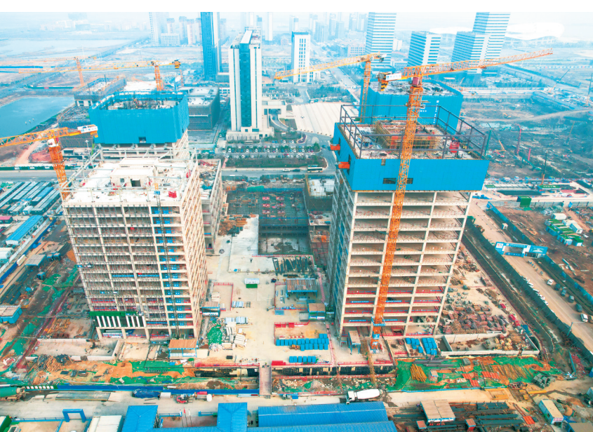
上合组织国家青年创业中心主体结构即将全部封顶。
