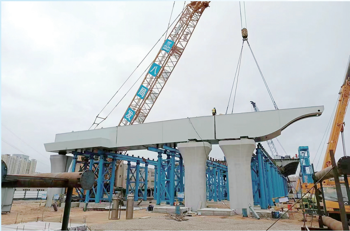
■跨海大桥高架路二期工程建设现场,工人和机械配合开展钢箱梁吊装作业。
