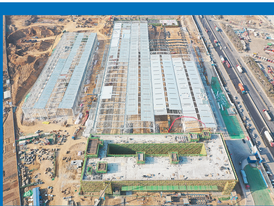
春节假期,潍柴(青岛)智慧重工智造中心项目加紧施工。 王 凯 摄
