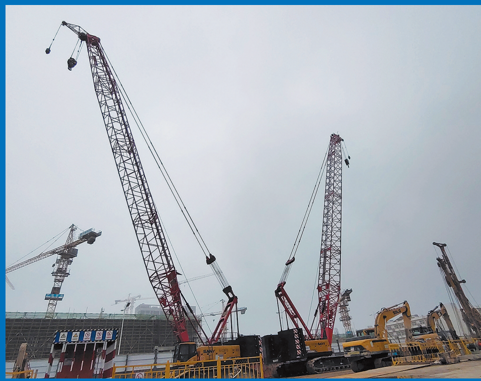
春节假期期间,2号线二期汉川路站全力冲刺围护结构施工。 周建亮 摄
