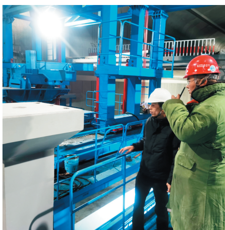
6号线建设者查看构件安装情况。周建亮 摄
