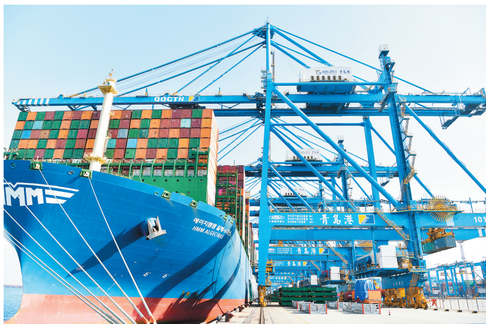
除夕当天,山东港口青岛港泊位饱满、大船云集。
