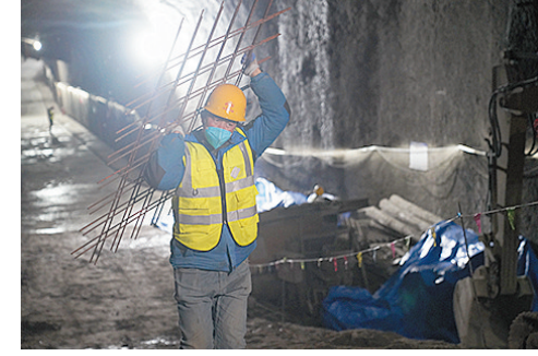
支护工范恩海正在运送支护材料。周建亮 摄
