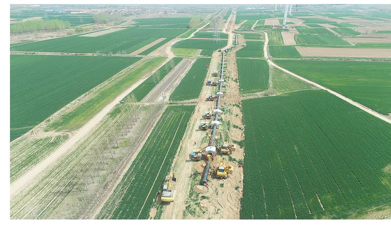
►胶州湾海底天然气管线工程陆域段全自动焊接DN1000管线施工现场。
