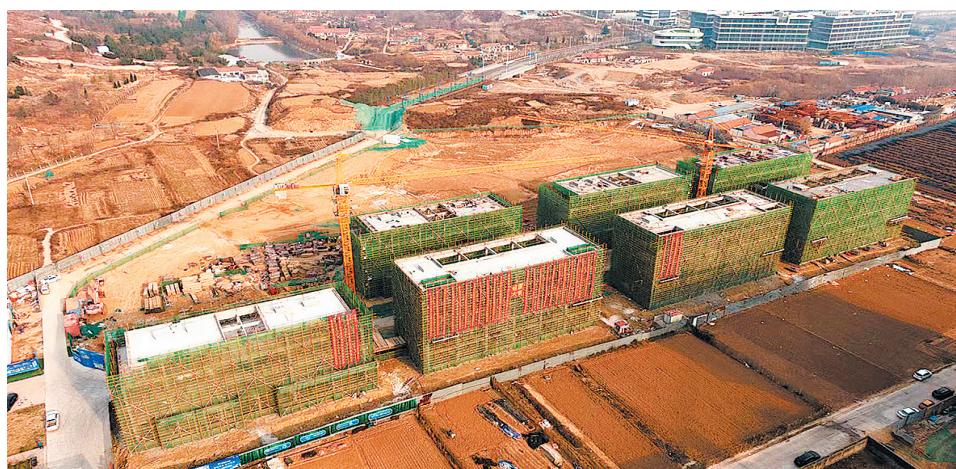
■山东省机器人产业园项目建设现场。
