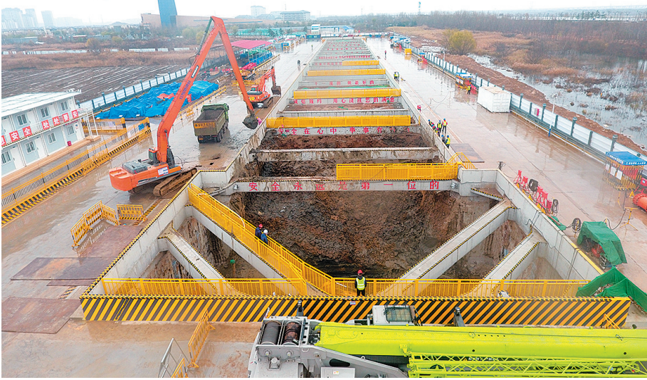
■8号线支线大沽河博物馆站正在开挖基坑。
