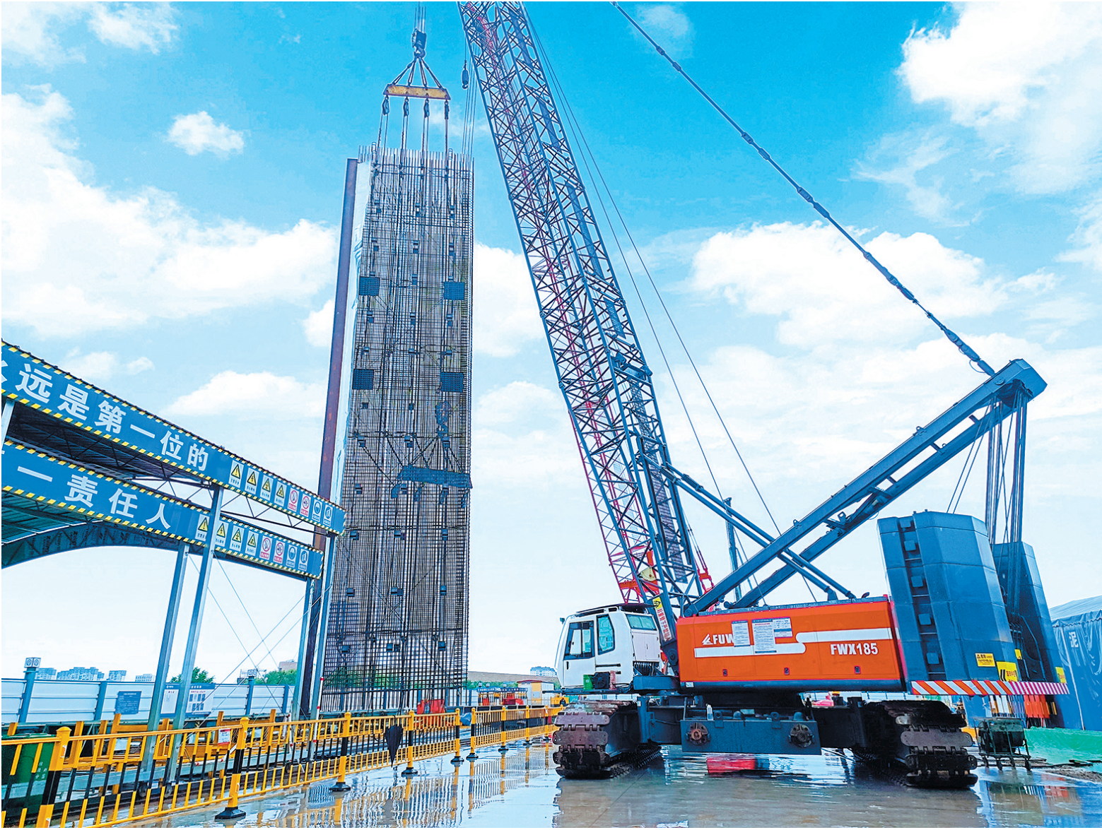
■在地铁工地上随处可见的吊装钢筋笼。
