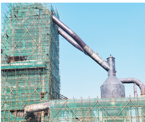
青钢遗址公园及工业文化遗存保护加固项目正在实施除锈喷漆作业。
