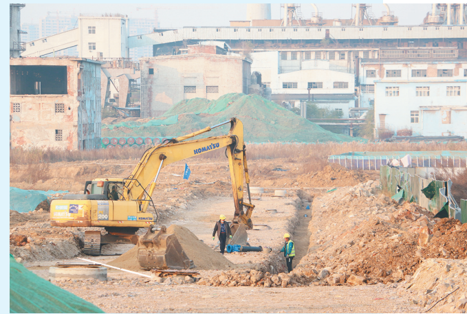
碱厂片区配套道路管线铺设施工现场。
