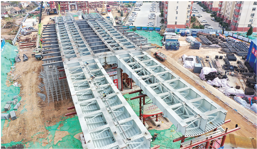
◀目前，跨海大桥高架路二期工程正在开展预制钢箱梁架设工作。
