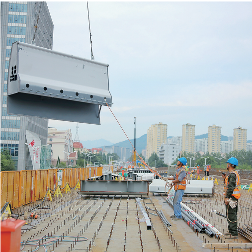
■海尔路-银川路立交工程主桥施工阶段，工人们配合着机械吊装装配式钢防撞体。
