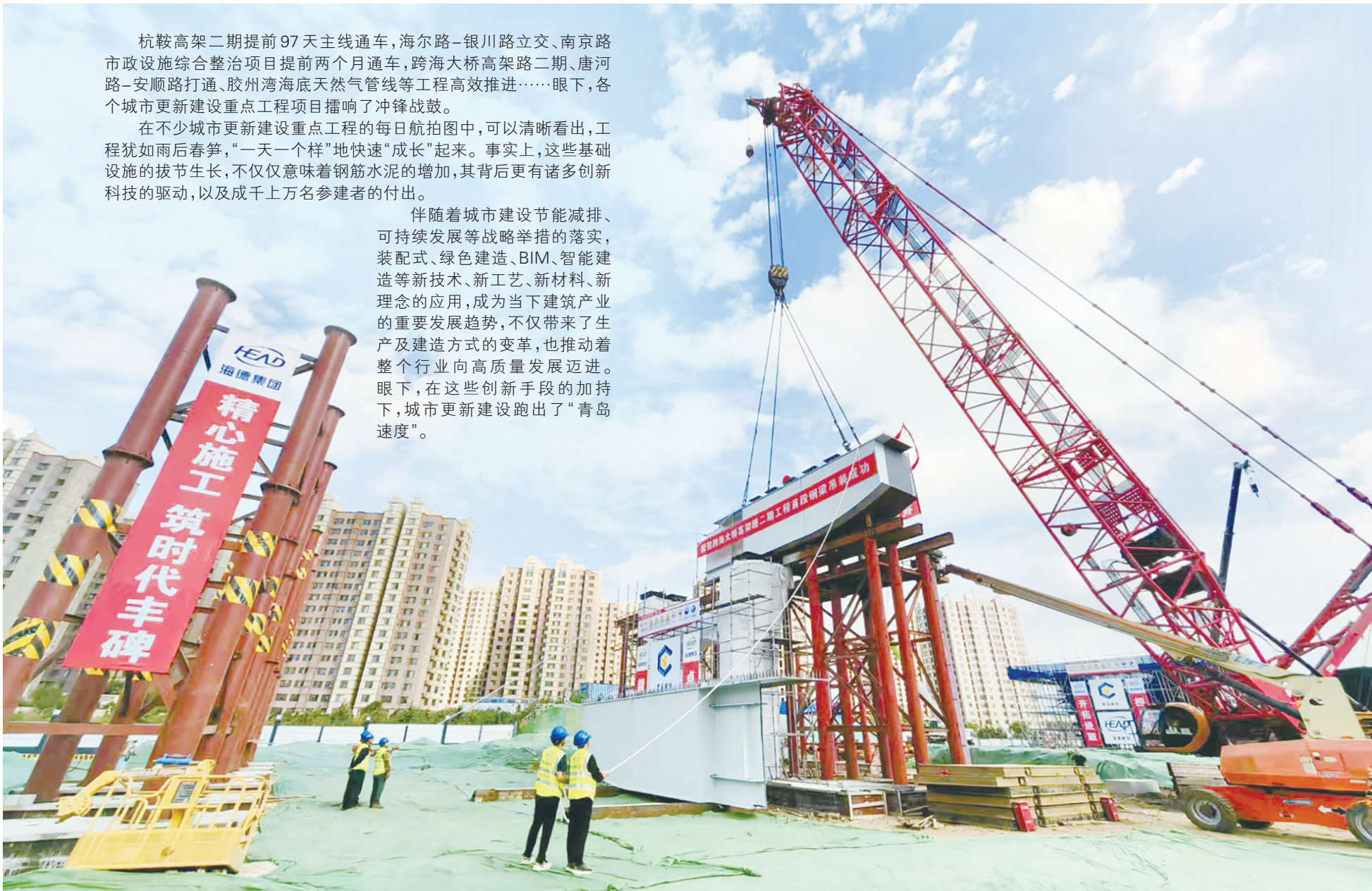
▲9月30日，跨海大桥高架路二期工程首节钢箱梁架设成功。
