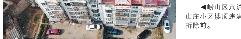
崂山区京沪山庄小区楼顶违建拆除前。
