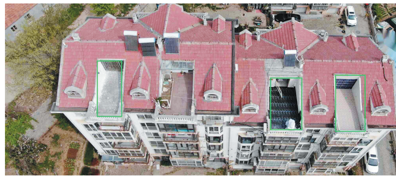
崂山区京沪山庄小区楼顶违建拆除后。
