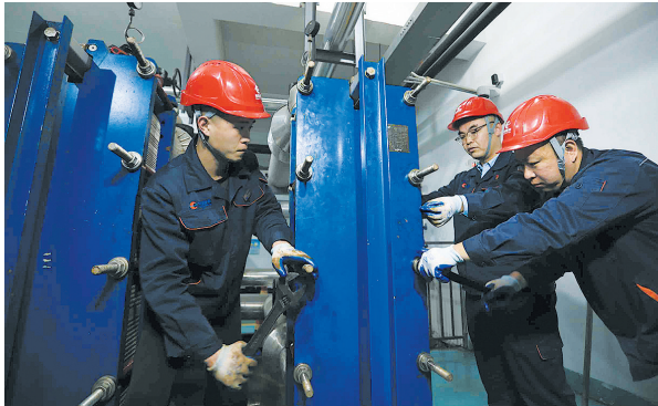
■青岛能源热电集团的供热工作人员正在清洗换热器，清除污垢，提高换热效果。
