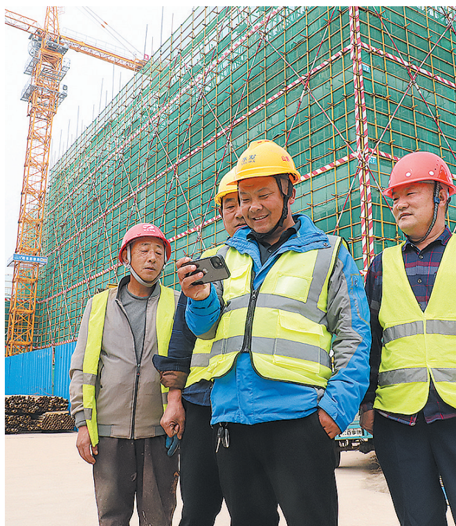
■青岛一建筑工地上，几位建筑工人通过手机收看党的二十大开幕会盛况。 李德银 摄
