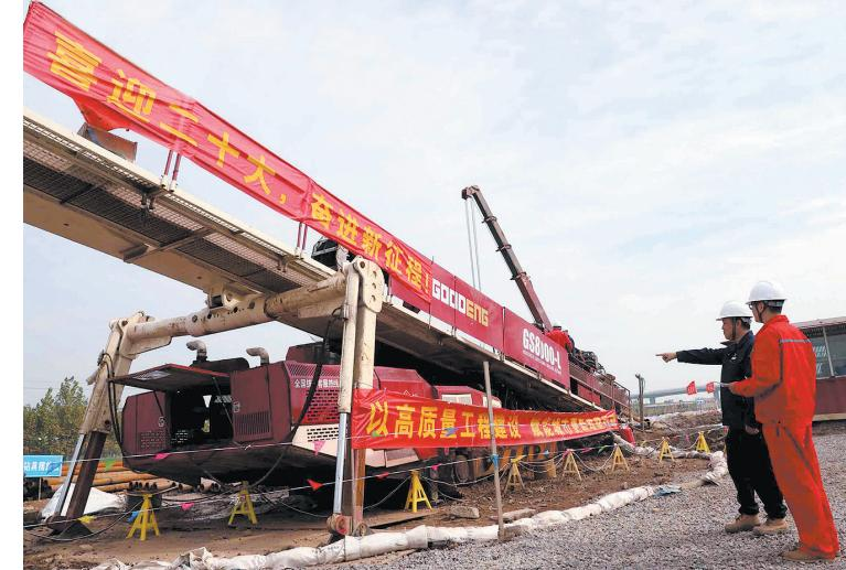
■在大沽河西岸,胶州湾海底天然气管线大沽河定向钻穿越工程正在24小时不间断施工。
