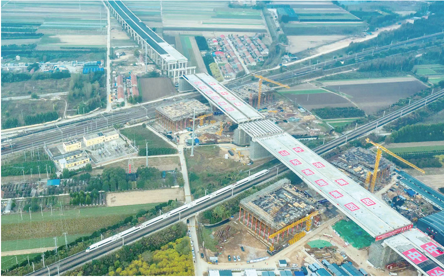
■潍青高速跨胶济客运专线、胶济铁路两个连续 T 型钢构转体桥完成转体。
