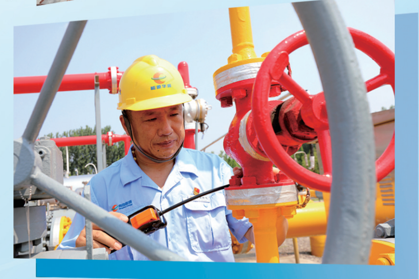
■青岛能源华润燃气工作人员检修燃气管线，保证供气安全。
