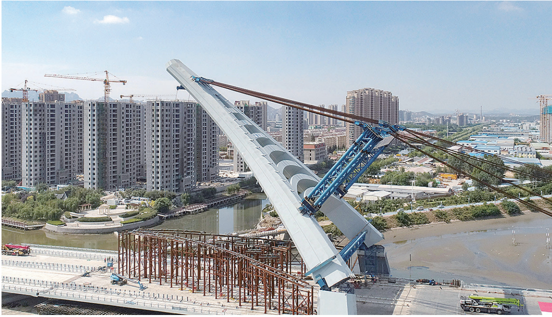
■9月25日,西海岸新区跨风河新建桥梁工程海口路桥主塔正在转至设计位置。张进刚 摄
