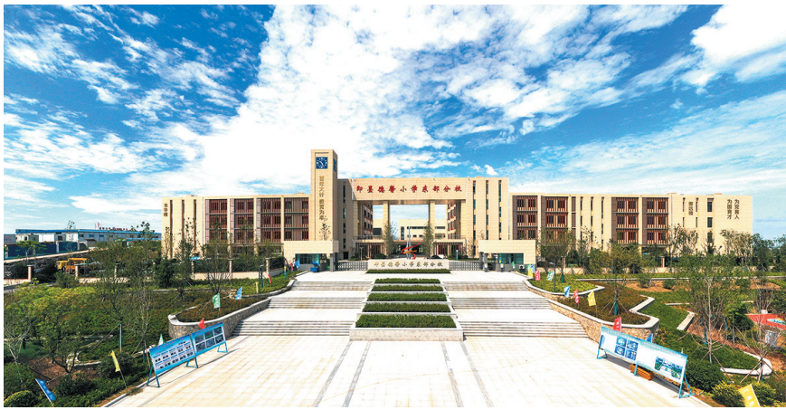
■新建即墨德馨小学东部分校。
