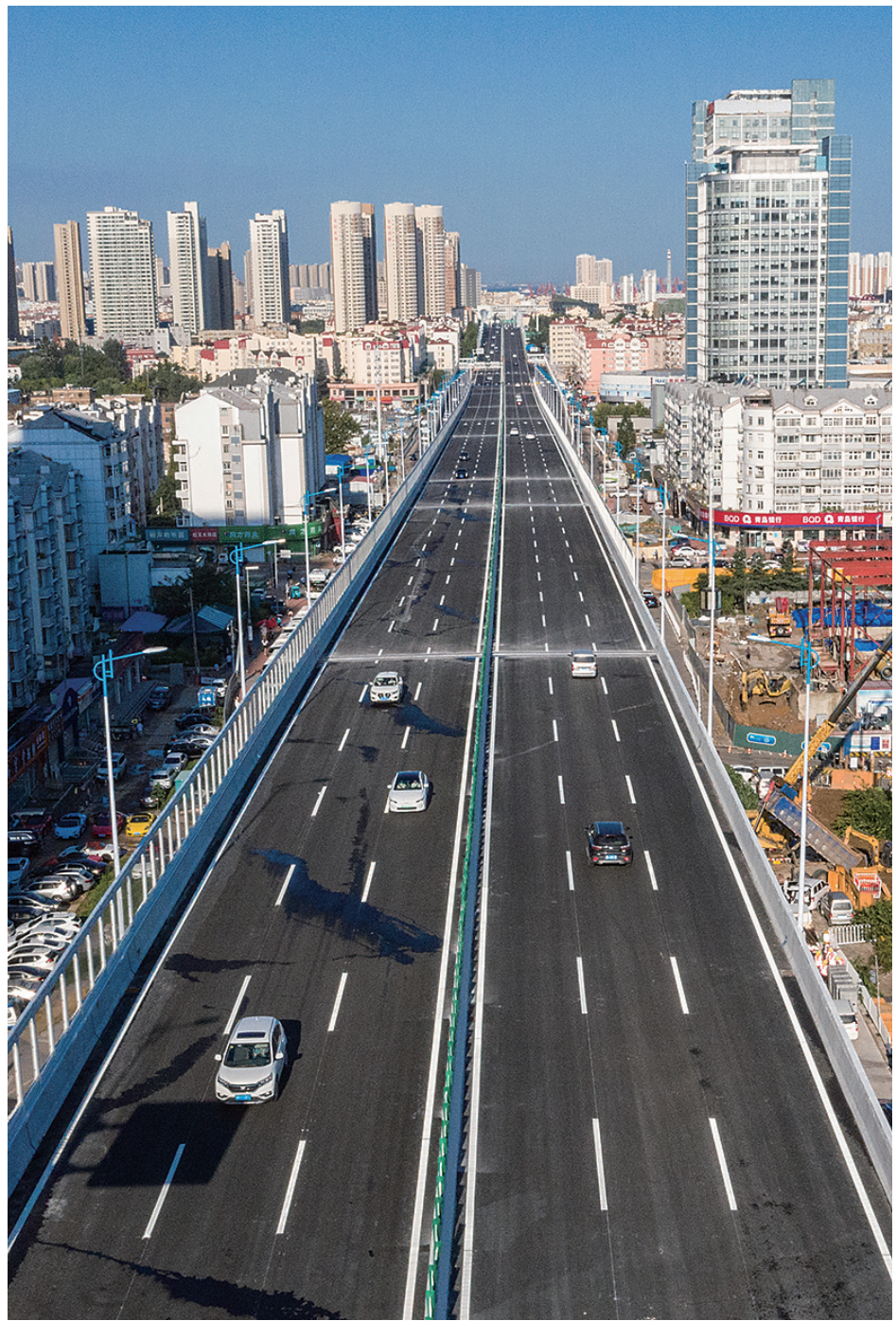
■8月23日7时,辽阳路(南京路-福州路段)交通结建工程主线桥通车。 刘 栋 摄
