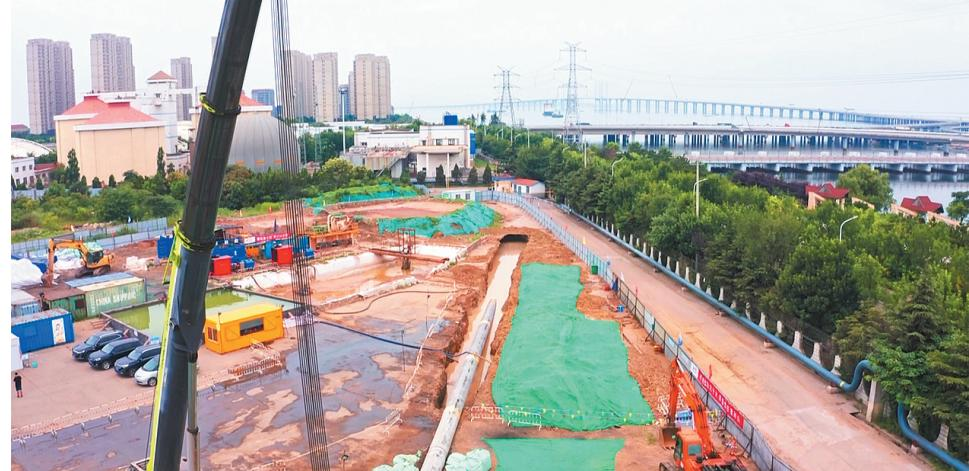
长管线在800吨推管机和海上作业船舶协同作业下,完成从陆地到海底的穿越,实现陆海连通。
