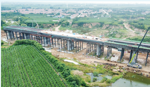
■潍烟高铁平度段施工现场。
