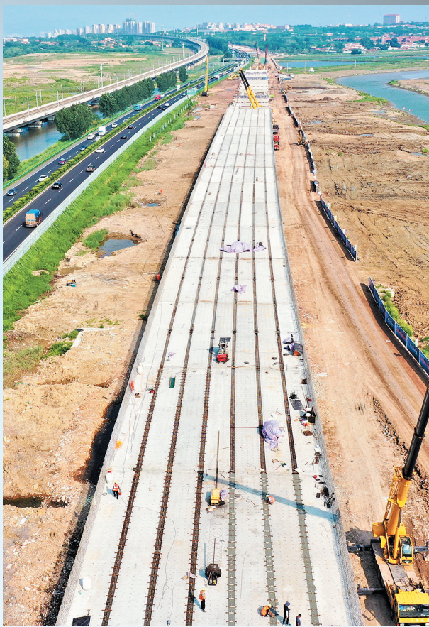
■青兰高速公路双埠至河套段改扩建工程施工现场。傅学军 摄
