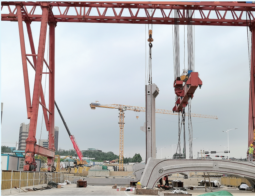
■由青岛市政空间开发集团城轨公司承建的地铁6号线07工区河洛埠站装配式结构正在加紧拼装。周建亮 摄
