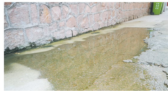
■市南区诚基公寓和南京路小区之间的道路上污水横流。
