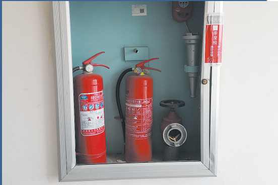
■城阳区天泰城·迦南美地小区65号楼电梯厅内的消防栓缺少水带,阀门成了烟灰缸。
