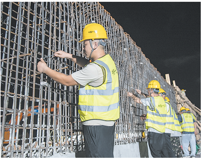
■施工人员正在捆扎钢筋。 刘 栋 摄
