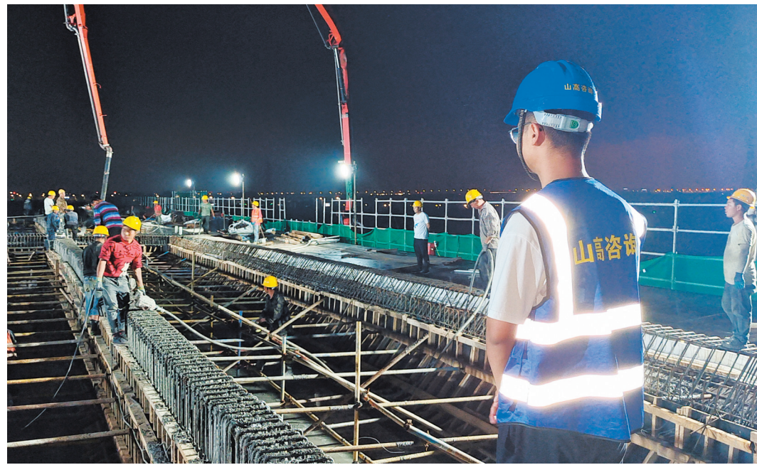
入夜,国道204大沽河桥梁工程加紧箱梁浇筑施工。 周建亮 摄
