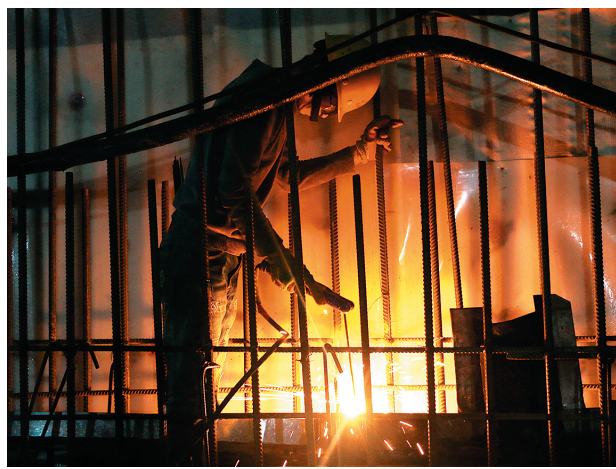
青岛地铁6号线创智谷站,施工人员在地下40米深的施工现场焊接固定止水带。 梁超 摄
