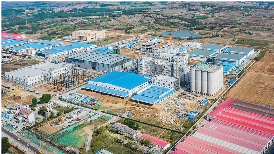
■益海嘉里项目正抢抓工期加快施工。
