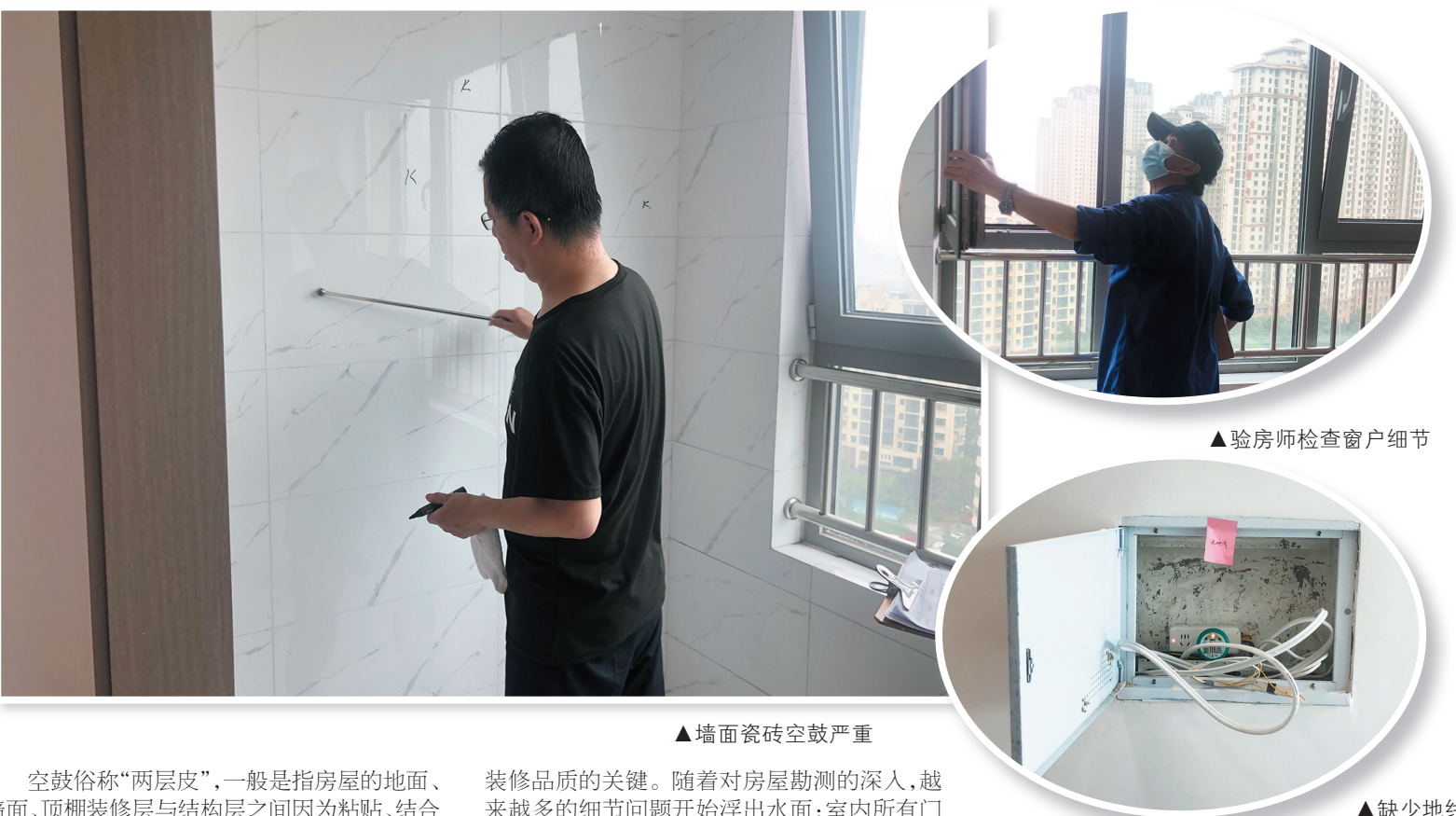
▲墙面瓷砖空鼓严重 ▲验房师检查窗户细节 ▲缺少地线
