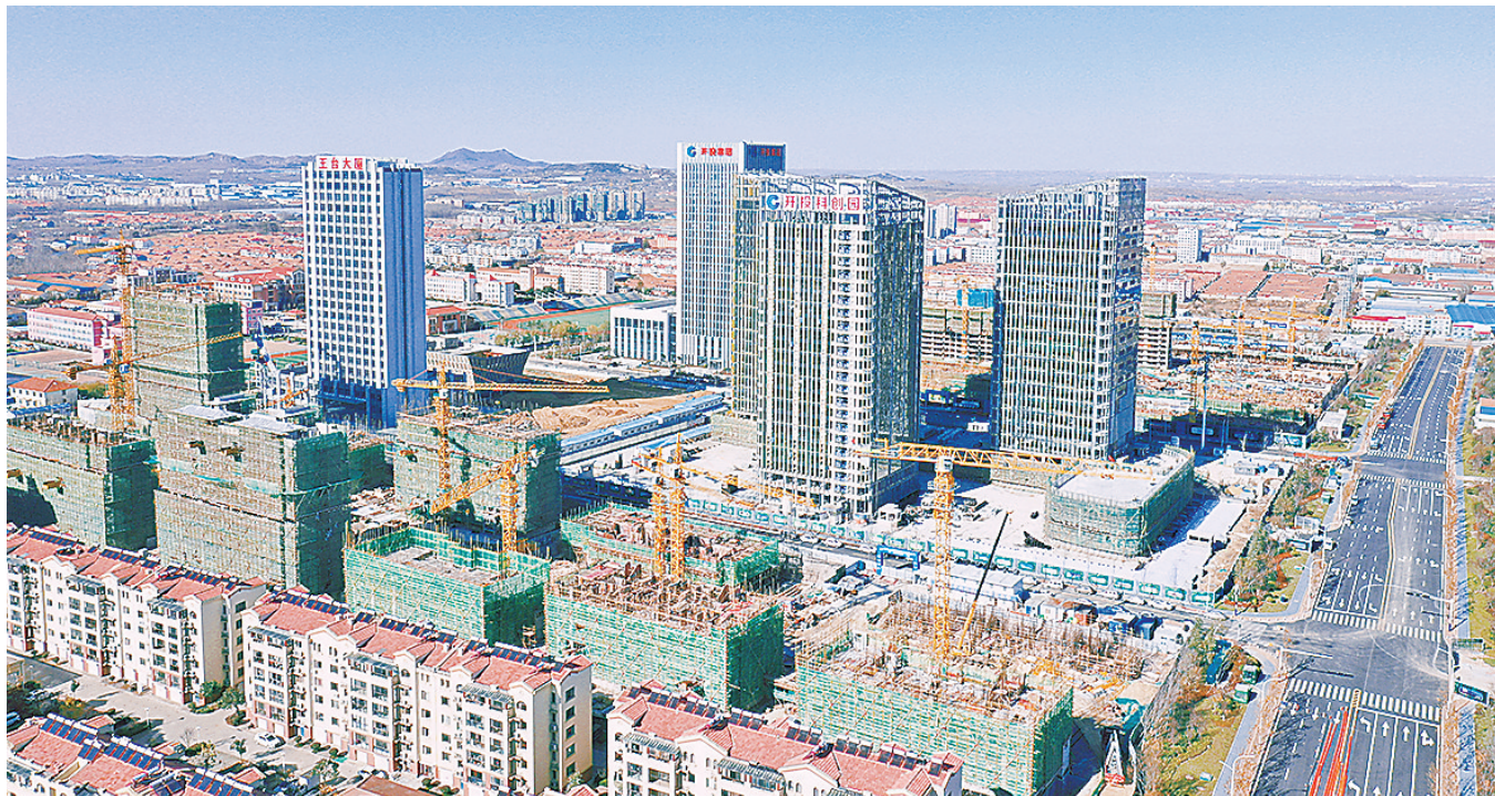
建设中的王台街道芯屏产业新城。
