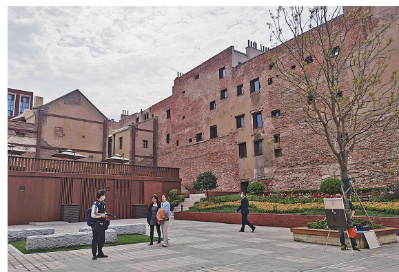
已建成并对外开放的易州路广场。
