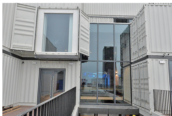
国际邮轮港区启动区山东港口集装箱部落项目已完成竣工验收。
