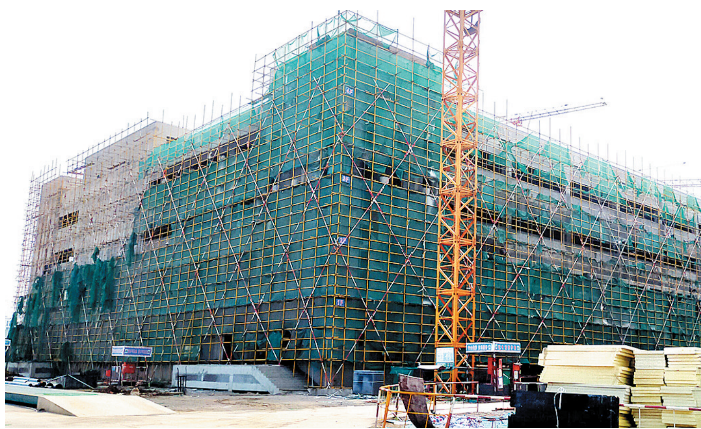
■位于即墨环秀街道的容科机电项目实现主体封顶。王涛 摄
