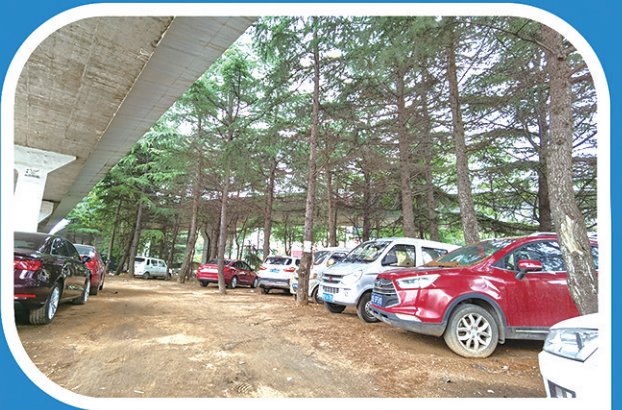
■青银高速连接段高架下方乱停车现象严重。
