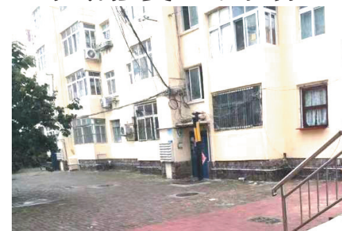
■市南区徐州路33号楼院西侧护栏缺失近3个月,至今未维修。
