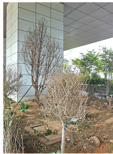
■地铁11号线浦里站高架建筑下方绿植枯死。
