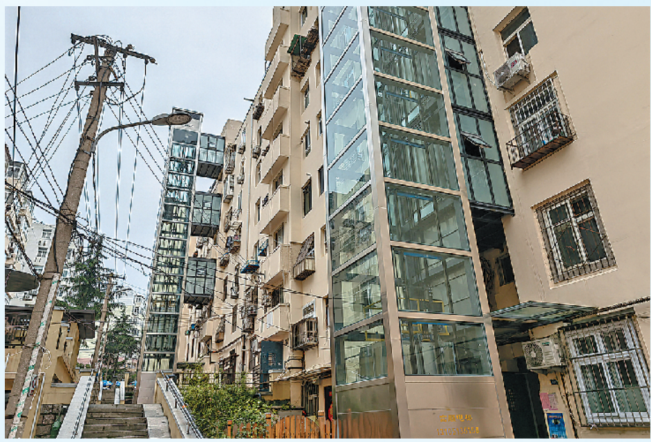
■市南区西藏一路28号楼的居民“喜提”电梯。
