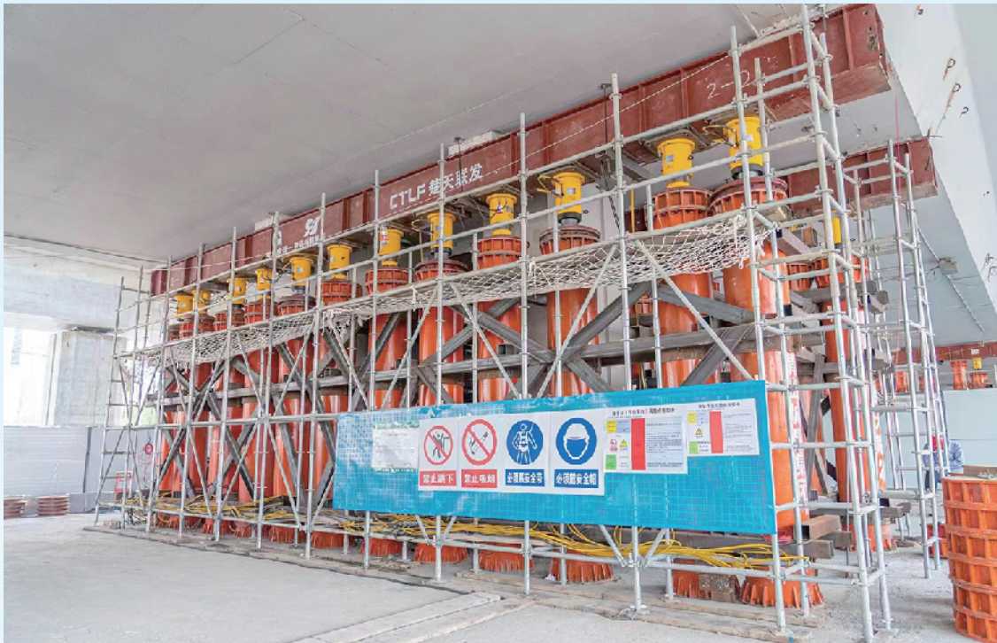
■近万吨的旧桥被“顶起”,最大高度达5.8米。 王冰洁 摄
