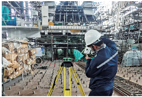
■干明义架设仪器测量数据，为相关设备精密安装提供数据支持。
