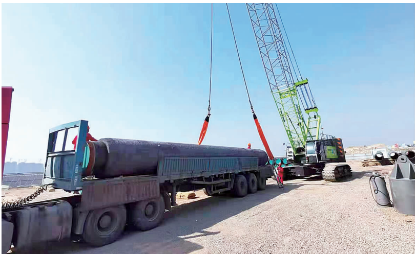
■浮拖现场吊装燃气管材。一根管材长12米、重达17吨。 贾 臻 摄
