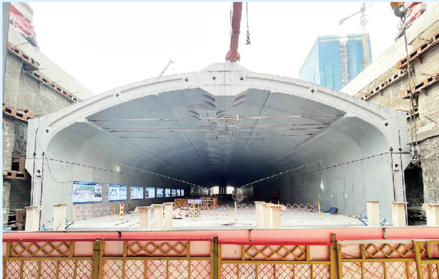
■4月27日，全国首座全方位装配式地铁车站——青岛地铁6号线可洛石站主体结构拼装顺利完成。
