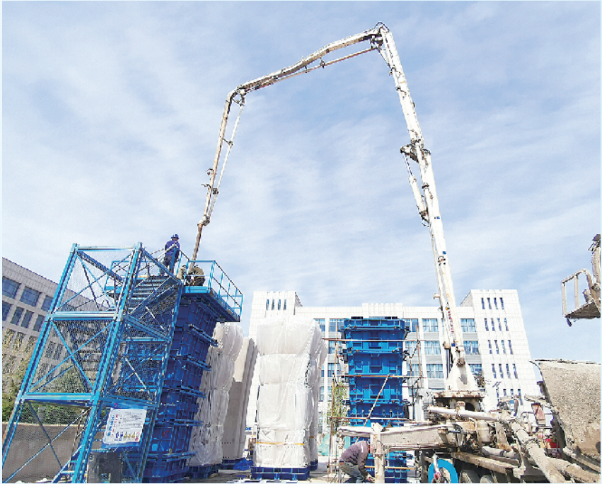
■工人们正在海尔路－银川路立交工程墩柱预制厂内忙碌作业。
