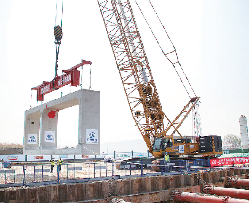
■唐河路－安顺路打通工程首节预制综合管廊安装完成。
