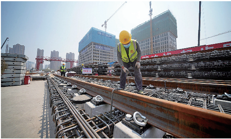
■在劲松四路站铺轨基地，中铁二十局集团有限公司施工人员正在进行轨排安装。周建亮 摄
