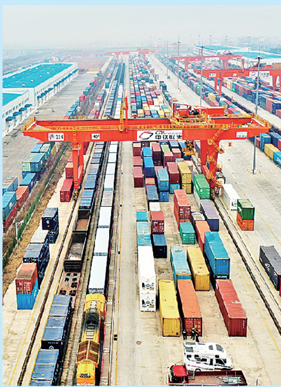
上合示范区青岛多式联运中心。傅学军 摄
