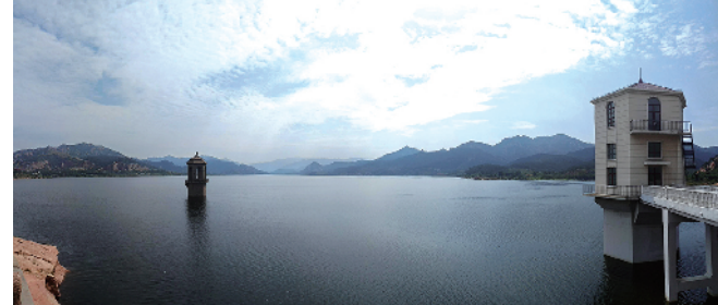
崂山水库蓄水量增多,水波荡漾。
