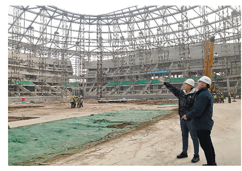
马明健(右)和城阳开发投资集团工作人员在现场检查施工进度。
