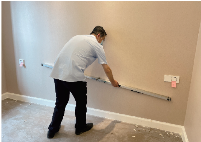
■检查对方方正度和墙面平整度
