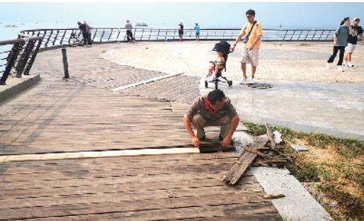
■施工人员正在修缮市南区金茂湾小区附近破损的滨海木栈道。
