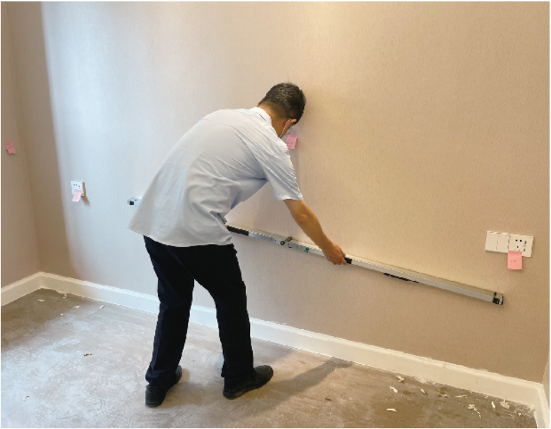
■验房师检查墙面平整度
