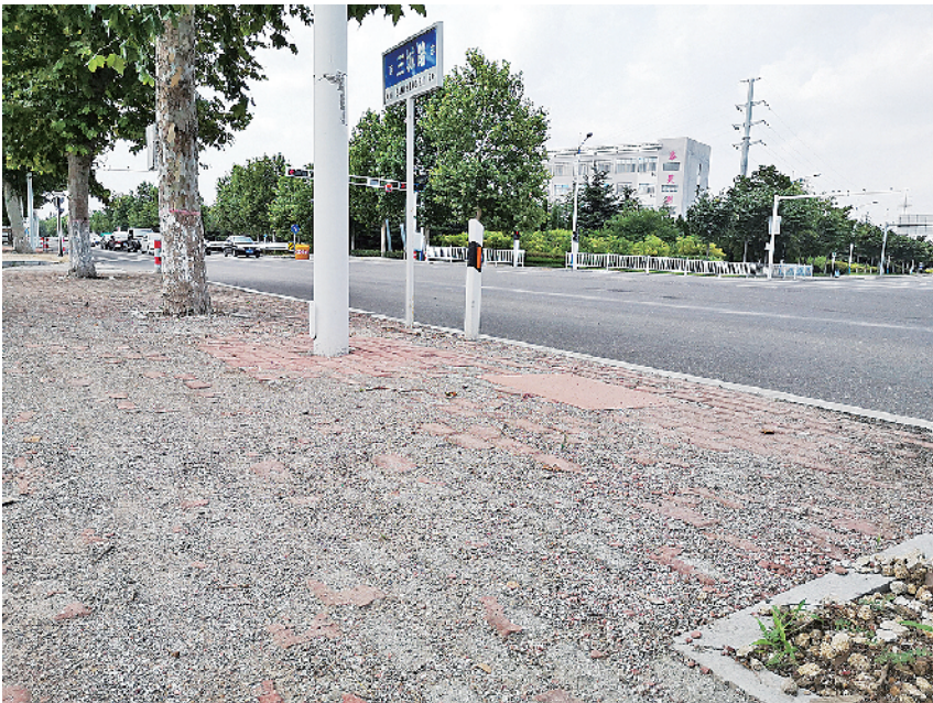
■平度市三城路南侧人行道的路面破损严重。
