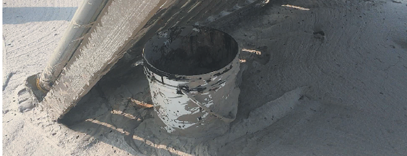
施工队将屋顶太阳能热水器连同废旧水桶浇筑在一起。
